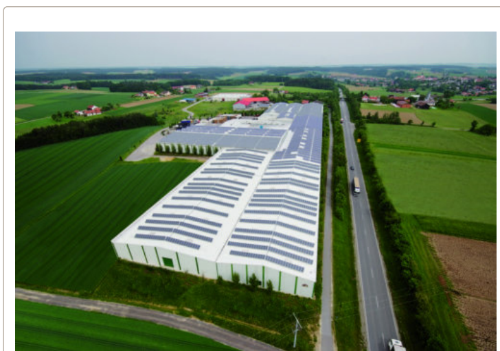
Photovoltaikanlage auf einem Firmendach in Simbach. Foto: KACO new energy
